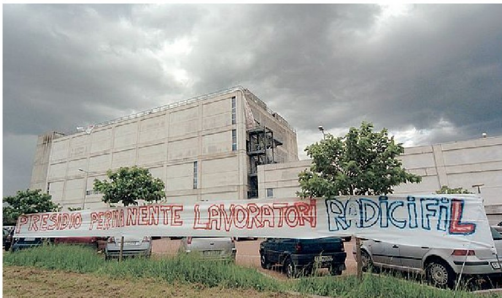
AMBIENTE La ex Radicifil è chiusa da tempo, al suo posto si vorrebbe realizzare una centrale a gas
